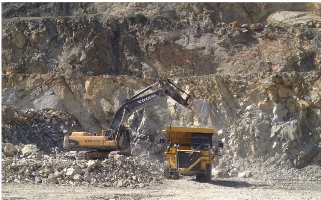
Figure 5 - Extraction du matériau en fond d'excavation
