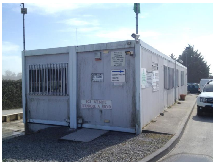
Figure 15 - Les bureaux et locaux sociaux
